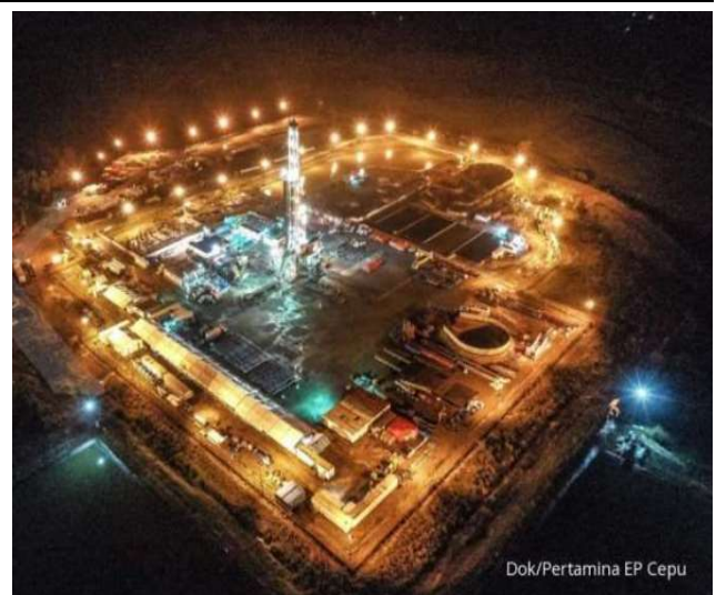
Fig 9. Jambaran Tiung Biru (JTB) gas project
